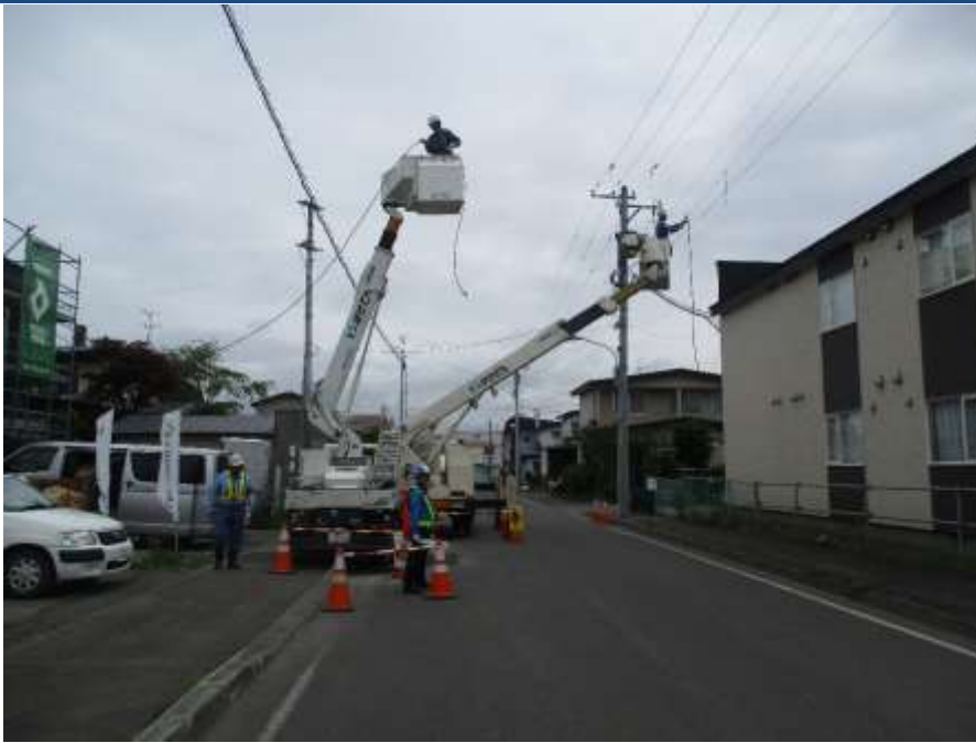
(配電工事現場写真)
